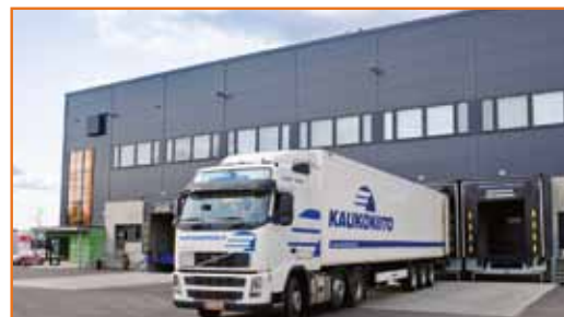
Scanoffice Oy:n toimisto ja logistiikkakeskus käsittää yhteensä noin 3750 m² nykyaikaista toimintilaneliötä.
